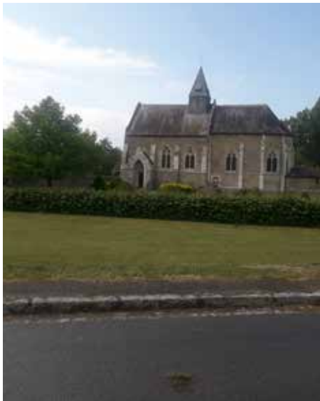
Toiture de l'église à prévoir
