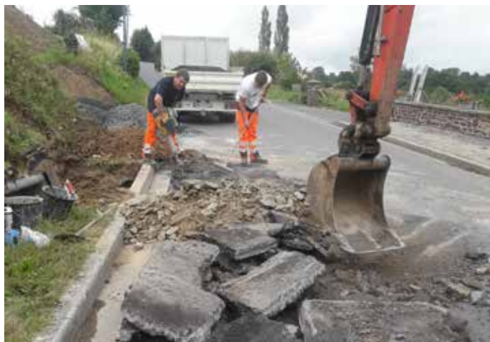
Passage de la fibre optique
