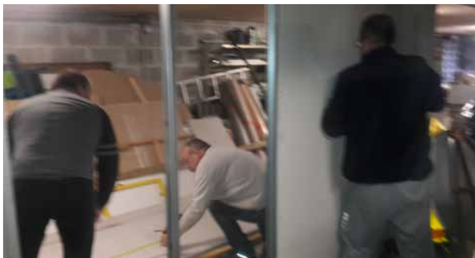
Pose de cloisons et d'étagères dans l'atelier pour optimiser l'espace
