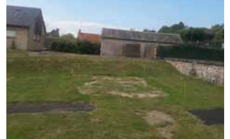
Terrassement derrière le local du comité
