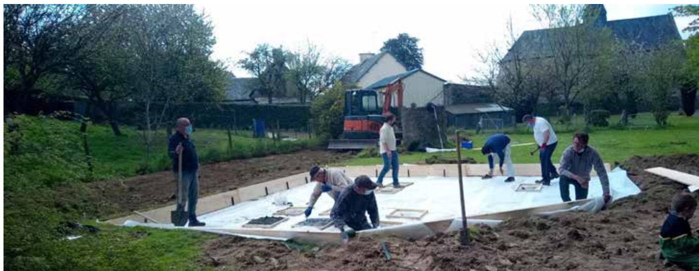
Le chantier du terrain de jeu
