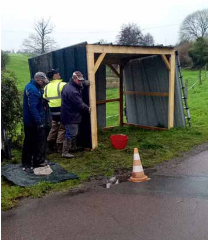
Construction d'un abri bus par deshabitants
